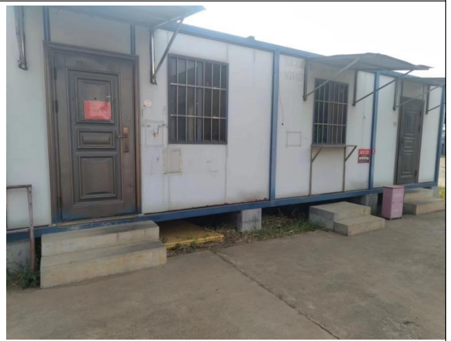
装置区应急器材室
