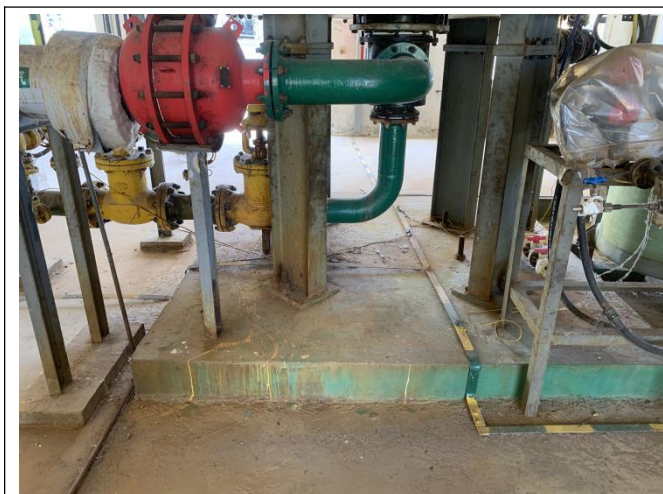
各机泵基础减振
