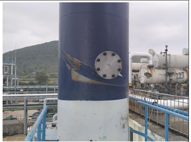
废气排气筒监测口 ↑
