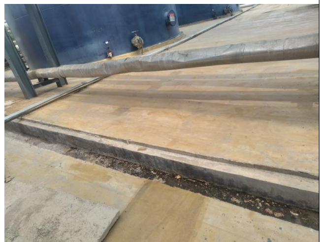
原料储藏区围堰及导排系统设置
